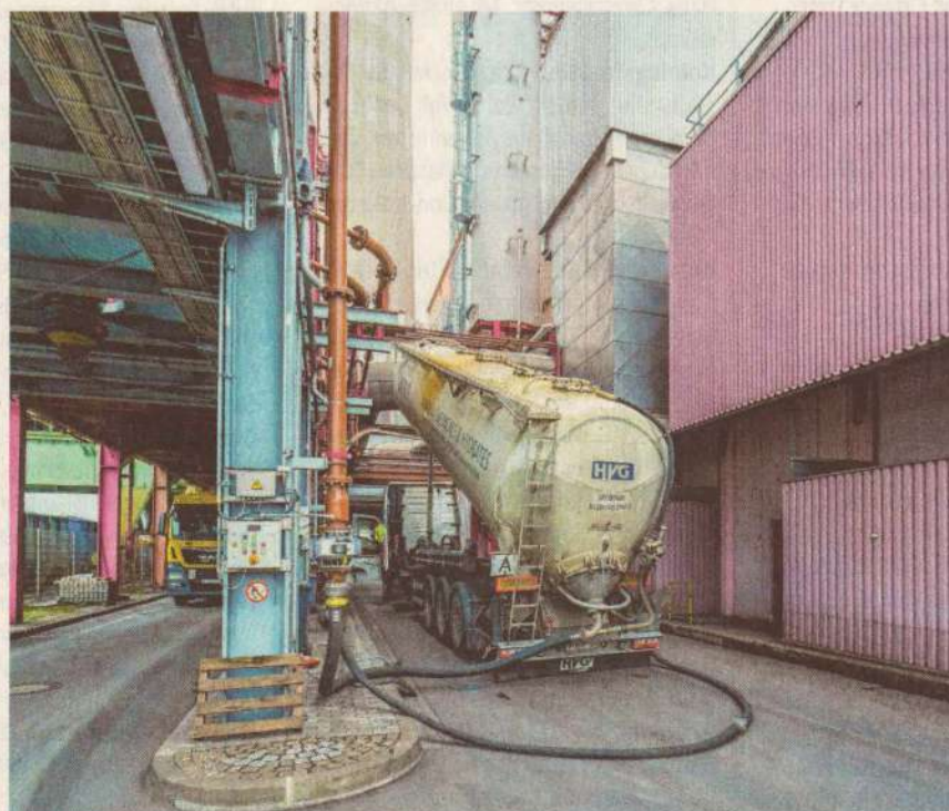
Unten Seit 2020 wird im Gemeinschaftskraftwerk Schweinfurt Trockenklärschlamm angeliefert – und verbrannt. Nach und nach soll er die Kohle ersetzen.
