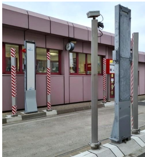
Abb. 3-12: stationäre Radioaktivitätsmessanlage
